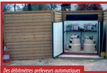
Des débitmètres-préleveurs automatiques réalisent les prélèvements d'eau en bas de pente des surfaces étudiées.
