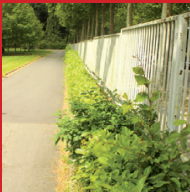
Haie inutile : doublement d'un grillage
