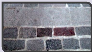
► Pavés en granit avec joints ciment
