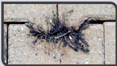
► Désherbage thermique entre pavés autobloquants
