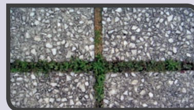
► Végétation installée aux joints des dalles de béton
