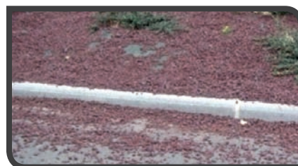
Au bord des allées, les massifs en surhauteur posent les problèmes de ruissellement et débordement des paillages qui favorisent l'installation des plantes sur les revêtements de circulation.
