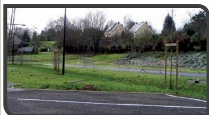
Il est souhaitable de réaliser des bordures végétalisées larges et à niveau. Ce dispositif anticipe les problèmes liés au désherbage.
