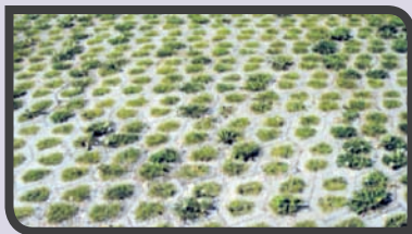
► Dalles alvéolaires intégrant une surface engazonnée
