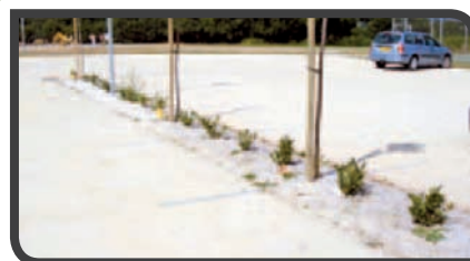
Les stationnements en stabilisé-ciment constituent une alternative mécanique et esthétique intéressante mais elle n'empêche pas la végétation. Il faut les entretenir par un grattage manuel ponctuel mais régulier.
