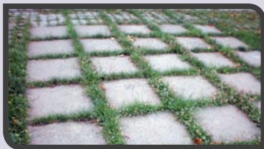
► Pavés béton avec joints larges
